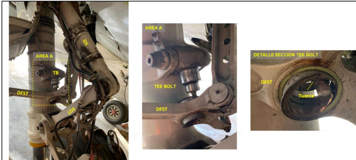
Fotografía No. 2 - Detalle general de la ubicación y condición del Tee-bolt
